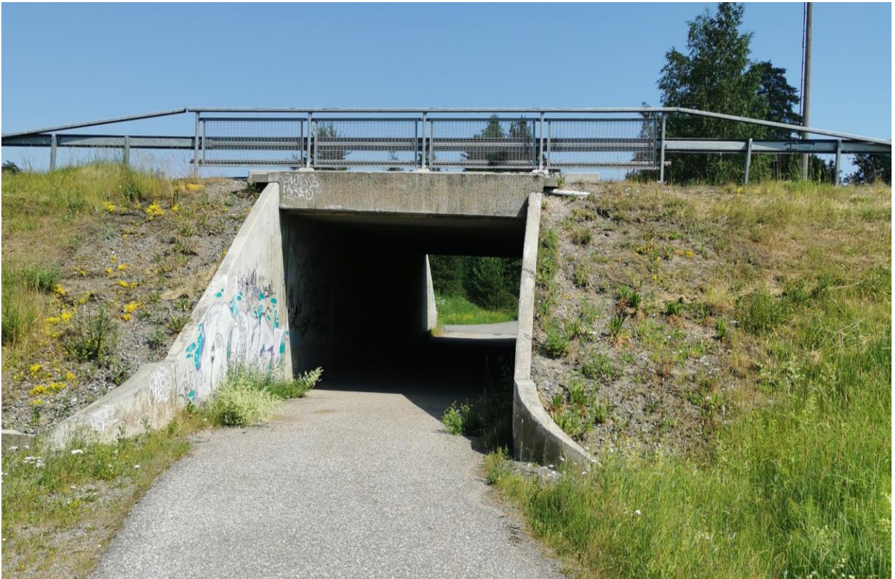
Kuva 10. Monninkylän alikulkukäytävä (Sweco 2022)
