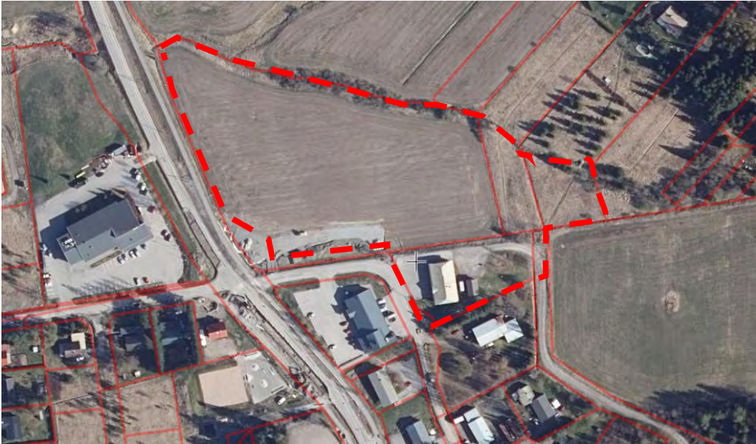
Alue Ilmakuvalla (2023). Kiertoliittymän rakentaminen on kuvassa vielä työn alla. C Maanmittauslaitos
