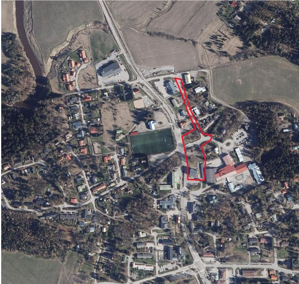
Ilmakuva taajamarakenteesta, kaavamuutosalue merkitty punaisella
