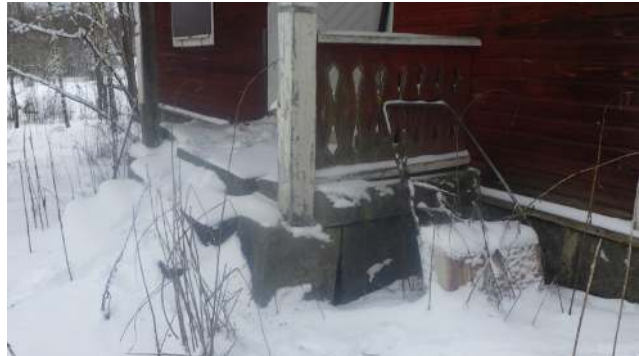
4. Sisäänkäynnin portaikko / katos uusittavassa kunnossa
