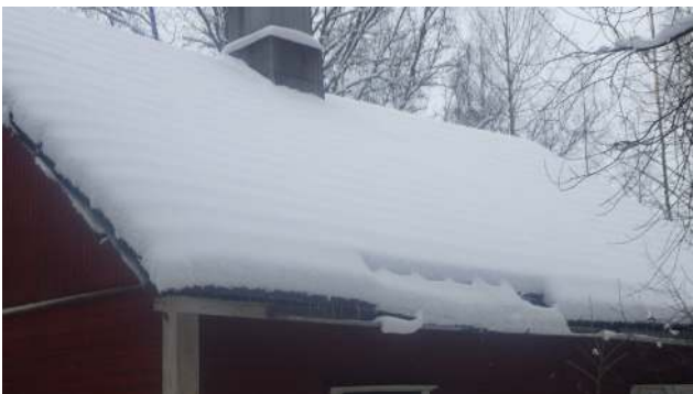
19. Vesikatto maasta kuvattuna
