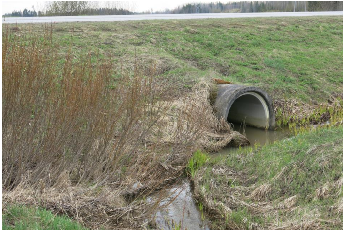
Kuivatusojan rumpu maantien ali.
