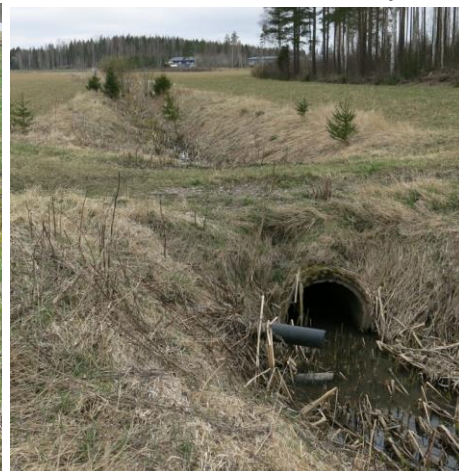
Maantien eteläpuolinen kuivatusoja.
