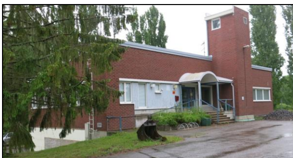
Julkisivun muutostyöt eivät ole kohdistuneet toiseen kerrokseen, kuva 2025
