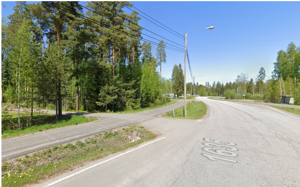
Kuva 19. Monninkyläntielle johtaa nykytilanteessa suora ajoliittymä Teollisuusalue II korttelin 102 tontille 3. Liittymä on välittömästi bussipysäkin edessä. Asemakaavan toteutuessa suora liittymä poistuu ja yhteys tulee toimimaan Tehdastien kautta (kuva Google streetview).
