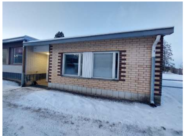
9. Puuverhousta käytetty ovien ja ikkunoiden yhteydessä.
