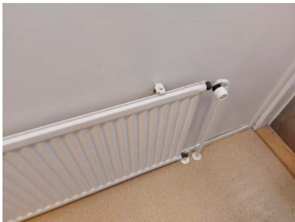
27. Käsisäätöinen patteriventtiili.
