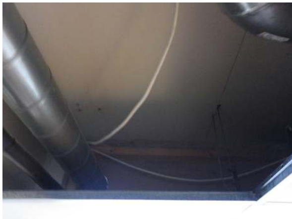
46. Sähköjohdot tulee kiinnittää alustaansa myös alas lasketun katon sisällä.
