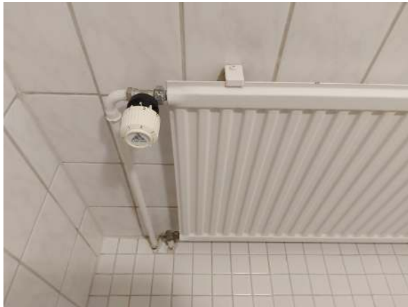
25. Termostaattinen patteriventtiili.
