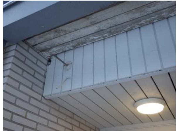
39. Rakenteisiin asennettu valaisin.
