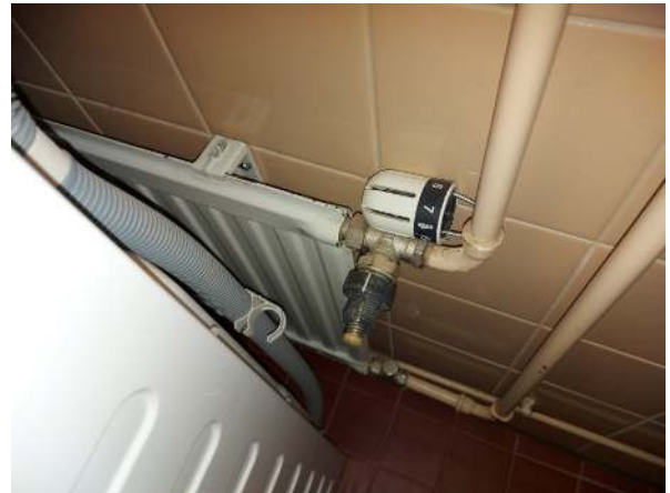
26. Lämpö ei riitä kaikkialla, koska termostaatti on irrotettu.
