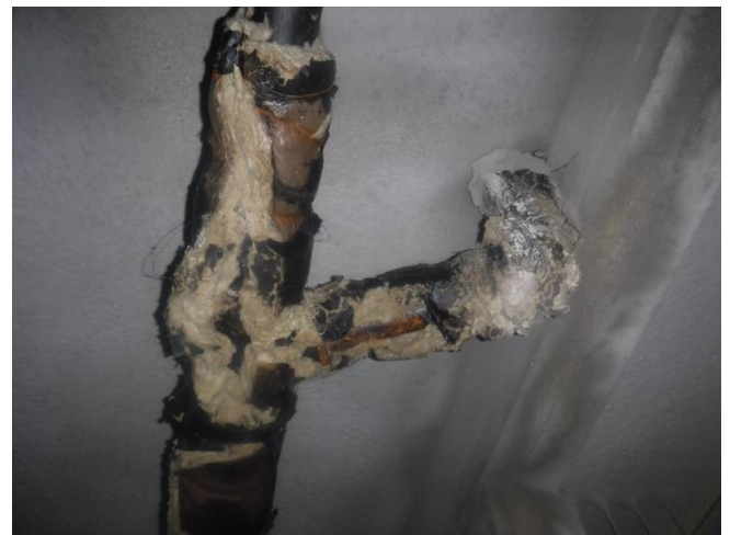
Kuva 6. Valurautaviemärit lävistävät alapohjalaatan
