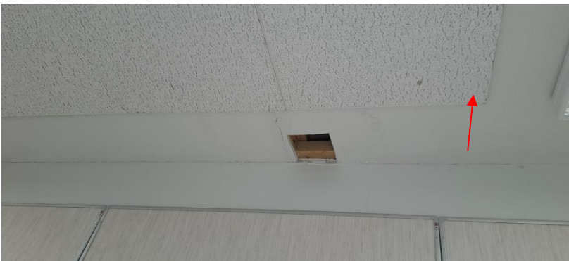
Kuva 27. Tilan 193 katon akusto-/alakattolevy ja kiinnitysliima ei sisällä asbestia (ASB19)
