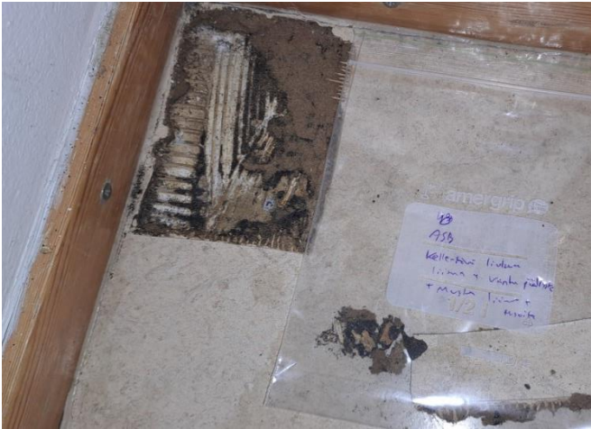
Kuva 9. Käytävän 173 kellertävä linoleumimatto, huopakeros ja musta kiinnitysliima eivät sisältäneet asbestia. (ASB1)
