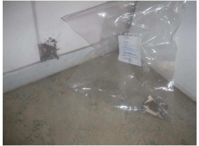
Kuva 18. Tilan 157, valkoinen seinälaatta, kiinnitys- ja saumauslaasti ja tasoite ei sisällä asbestia (ASB10)
