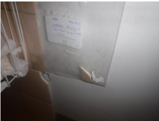
Kuva 19. WC:n 140, kellertävä seinälaatta, kiinnitys- ja saumauslaasti sekä tasoite ei sisällä asbestia (ASB11)
