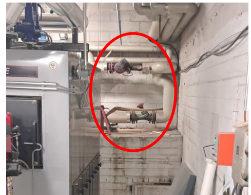
Kuva 8. Laippaliitoksia lämpökeskuksessa 042
