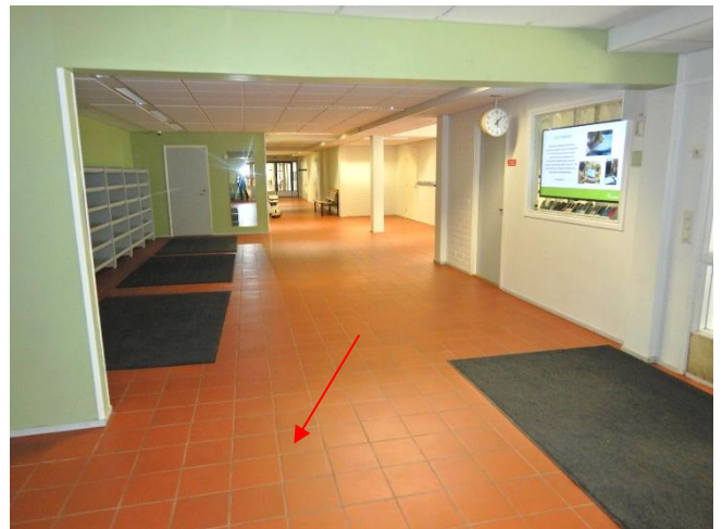
Kuva 16. Käytävän 142 punainen lattialaatta, kiinnityslaasti ja tasoite eivät sisällä asbestia (ASB8)
