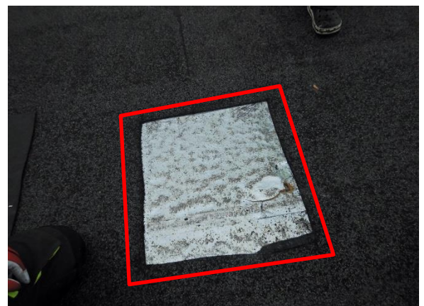
Kuva 24. Liikuntasaliosan vesikatteen bitumikermit ei- vät sisällä asbestia (ASB16)
