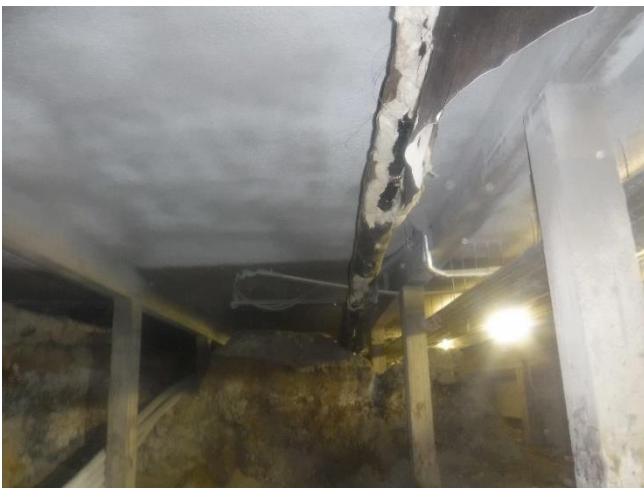
Kuva 5. Valurautaviemäreitä ryömintätalassa.
