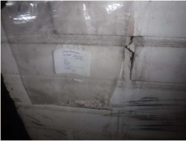
Kuva 25. Lämpökeskus 042 savukanavan tiilen saumalaasti ei sisällä asbestia (ASB17)
