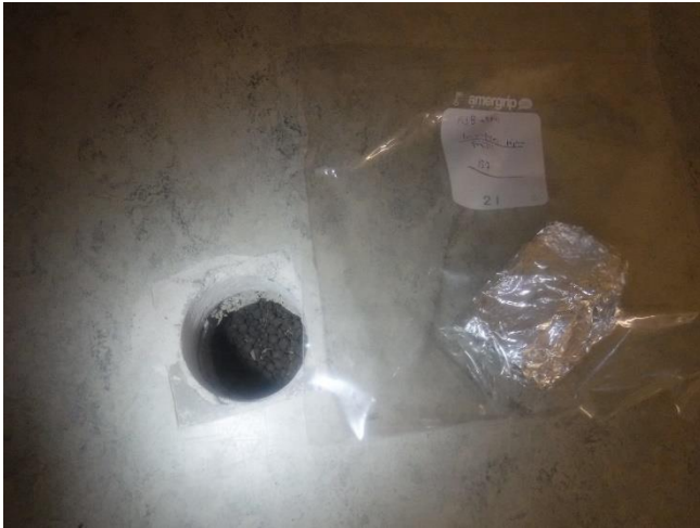
Kuva 21. Tilojen 157 ja 115 alapohjan tervapaperi pintabetonilaa- tan alla ei sisällä asbestia (ASB13)
