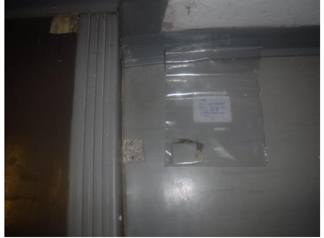
Kuva 14. Porraskäytävän 044 lattian harmaa muovimatto, kiinnitysliima, tasoite sekä portaan tumma muovimatto ja liima eivät sisällä asbestia (ASB6)
