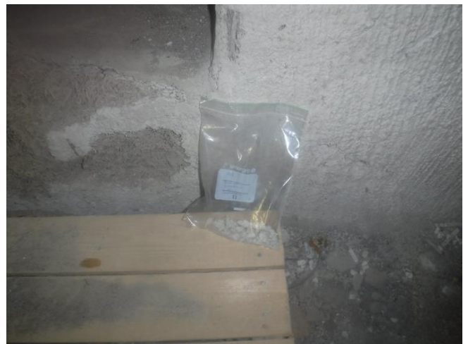
Kuva 20. Ryömintätilan, porraskäytävän vastainen, seinärappaus ei sisällä asbestia (ASB12)
