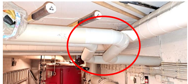
Kuva 2. Yleiskuvaa käyttövesiputkista. Asbestipitoinen eriste suojassa muovisuojakalvon alla.
