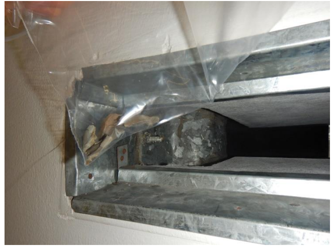
Kuva 26. IV-kanavan sisäpuolinen ruskea tiivistemassa ei sisällä asbestia (ASB18)
