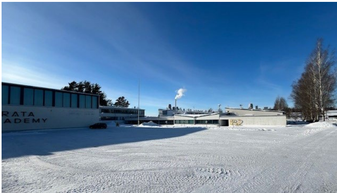
Kuva 12. Askola instituutin rakennussiivet muodostavat Helkamäentien suuntaan väljän aukiomaisen pihan, joka toimii pysäköintialueena.
