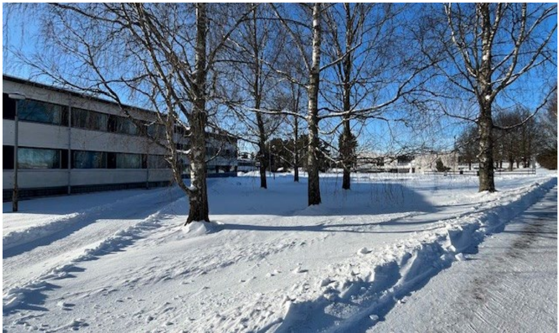
Kuvat 11. Vanhan lukion Helkamäentien puoleinen julkisivu. Taustalla ammattikoulun rakennus.
