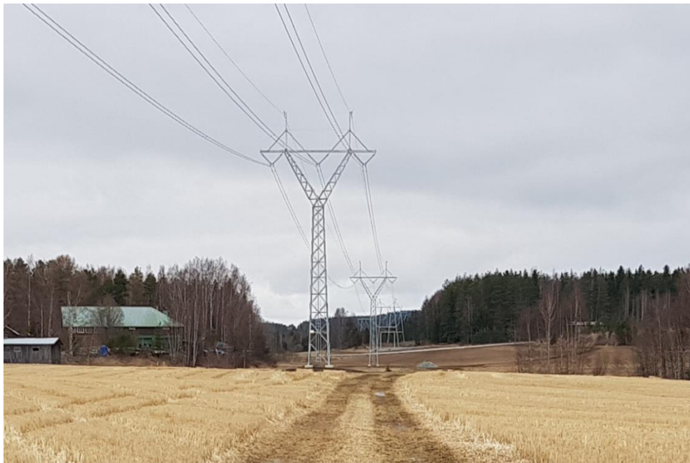
Kuva 1-5. Havainnekuva 1Y-tyyppisestä pylväsrakenteesta peltoaukealla.
